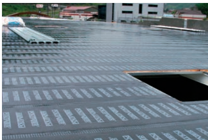
Sobre plancha metálica y grecada (deck)
